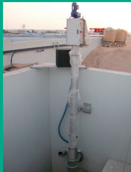
Schachtsiebanlage
