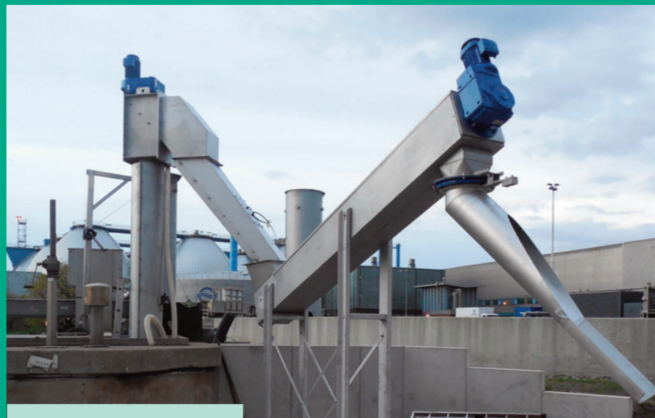
Schachtsiebanlage
